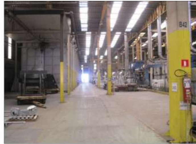
Galpão - Setor de pintura
