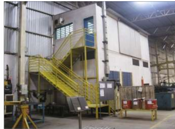
Galpão - Cabine de força e segurança do trabalho (vista interna)
