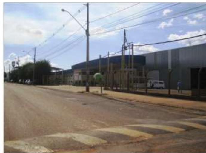
Fachada da Pedertractor
