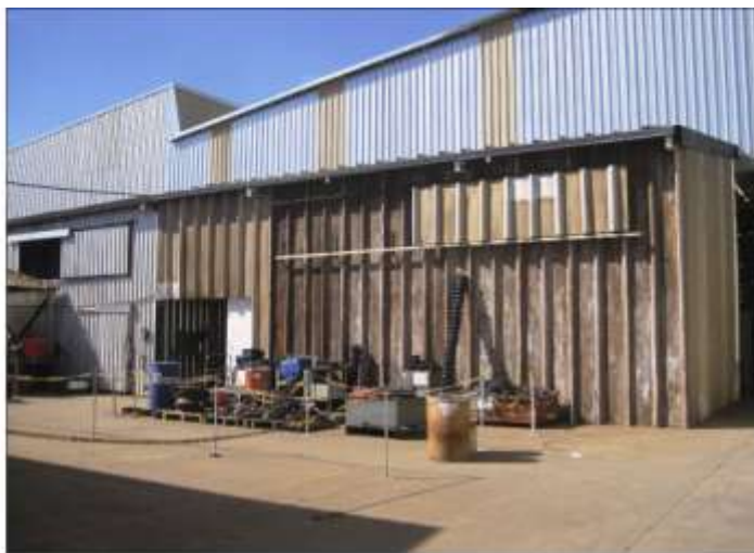
Galpão de manutenção elétrica
