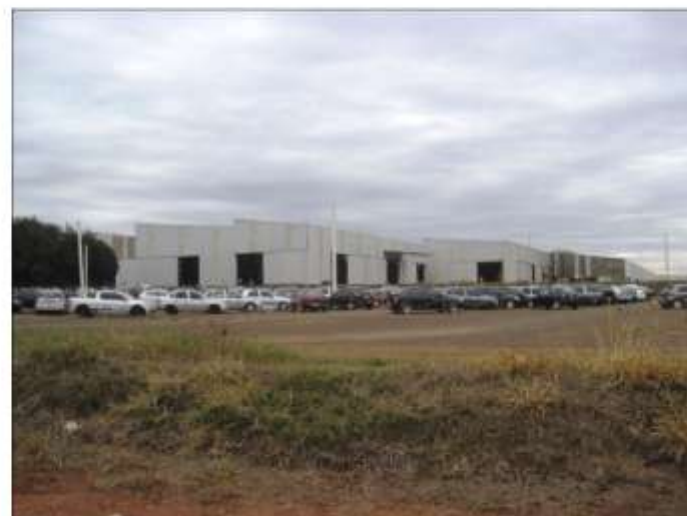
Vista do imóvel pela Rua Duque de Caxias
