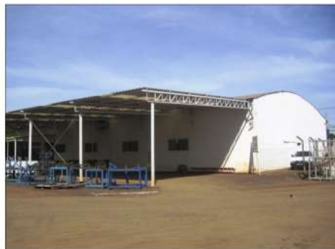
Refeitório e cobertura
