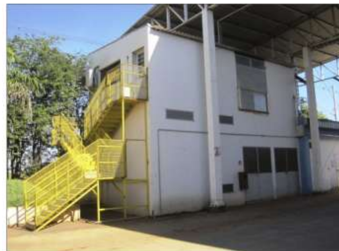
Cabine primária e escritório
