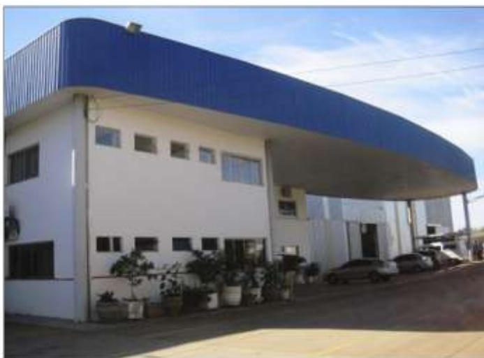
Cobertura da entrada
