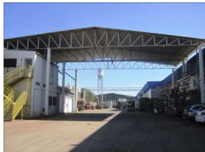
Cobertura da cabine primária
