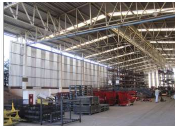
Galpão de expedição (vista interna)
