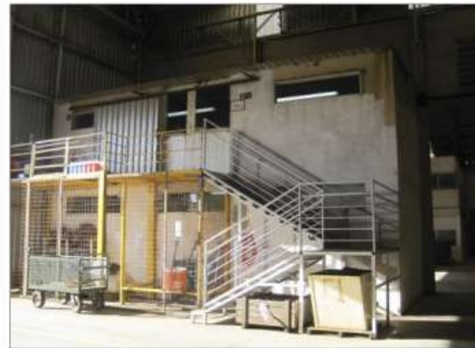
Galpão - Almojarifado (vista interna)
