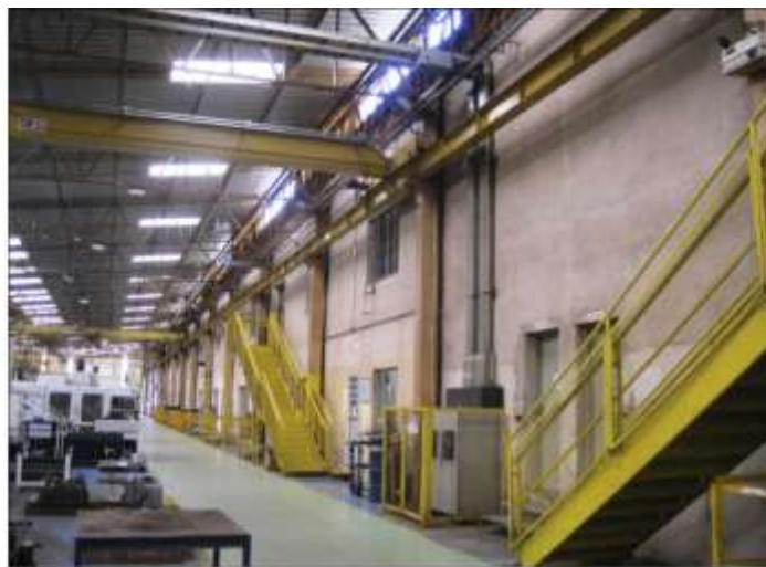
Galpão - Escritório (fachada dos fundos)
