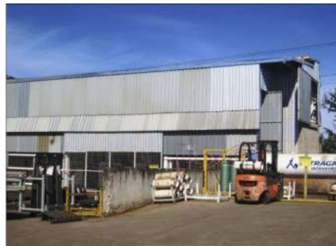
Barracão de gás e compressores
