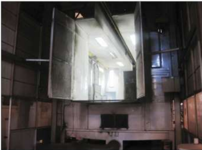
Galpão - Pintura em pó (vista interna)
