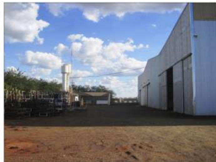
Fachada dos fundos do galpão
