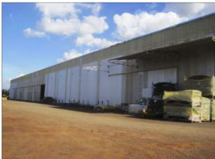
Fachada lateral do galpão
