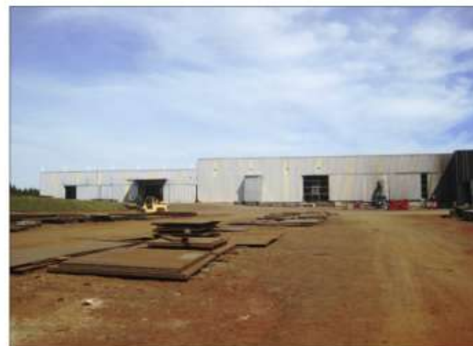
Galpão - Fachada dos fundos
