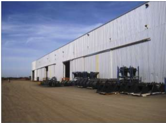
Galpão - Ampliação (fundos)
