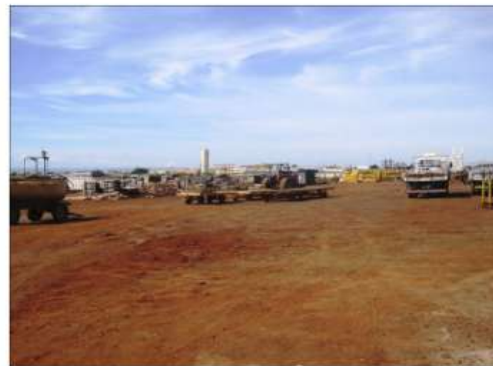
Vista geral dos fundos do imóvel
